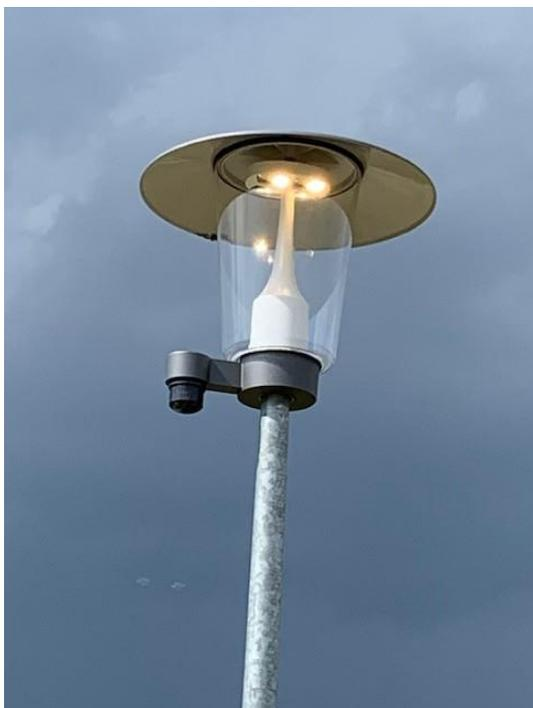
Abbildung 2: Pilz-Leuchte m. ZHAGA-Schnittstelle
