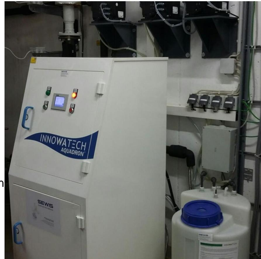
Basis der INNOWATECH AQUADRON® (MZE) -Technologie ist die elektrolytische Herstellung einer pH-NEUTRALEN Anolyte® -Lösung aus einer Kochsalzsole.
