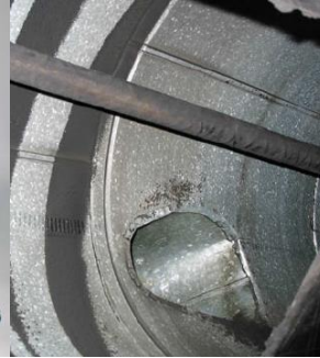
Rohrleitung nach der Reinigung
