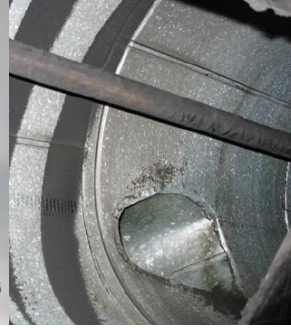
Rohrleitung nach der Reinigung
