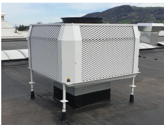
Abbildung 3: Eines der beiden Außengeräte der Smart Hall Cooling Lösung mit einer Luftmenge von 15.000 m 3 /h. (Abb. © INFRANORM)
