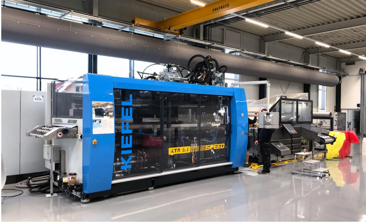
Abbildung 1: KIEFEL Packaging hat eine 2100 m 2 große Produktionshalle mit Smart Hall Cooling errichtet. Für eine deutlich verbesserte Raumluftqualität sorgt die zugfrei gekühlte Frischluft, die durch den grauen Textilschlauch oberhalb der Maschine eingeblasen wird. (Abb. © INFRANORM)
