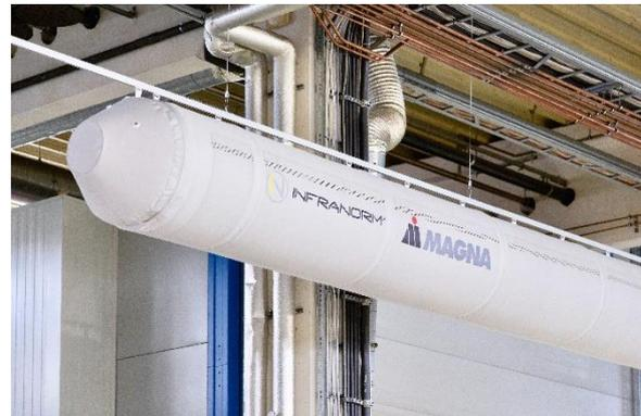
Abbildung 5: Mittels individuell gestalteter Perforation des textilen Luftschlauchs wurde die Einblasgeschwindigkeit und Wurfweite individuell an die Arbeitsplatz-Situation angepasst.
