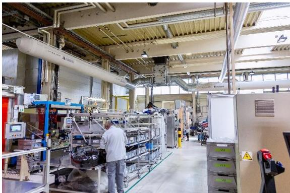
Abbildung 4: In zahlreichen Kühlzonen wird durch weiße Textil-Luftschläuche in Deckennähe die angenehm kühle Frischluft eingebracht.
