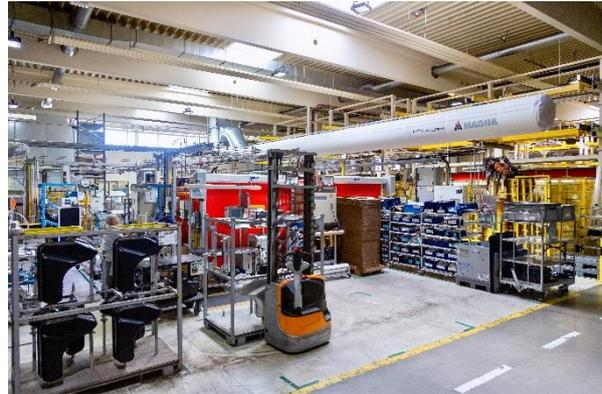
Abbildung 7: Arbeitsplätze mit bis zu 5m Entfernung zu den textilen Luftschräuchen werden mit angenehm kühler Frischluft versorgt.
