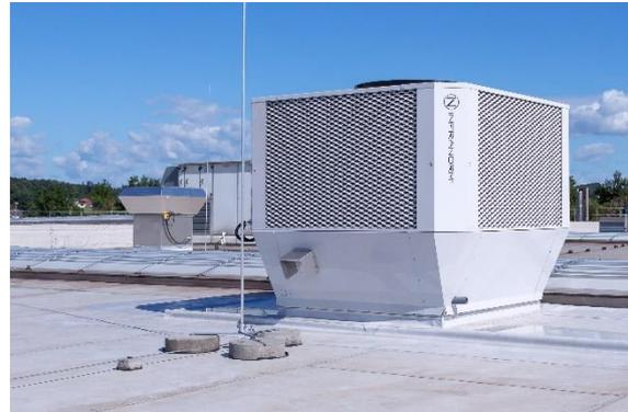
Abbildung 3: Eine der vier IntraCool Kühleinheiten, vom Hersteller OXYCOM, mit denen 14.000m<sup>3</sup>/h gekühlte Frischluft in die Halle einbracht wird.
