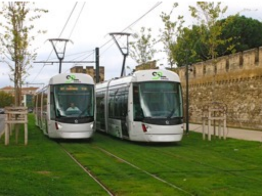
Rasengleis der Straßenbahn in Avignon Quelle: https://procitybahn.de/author/sk/
