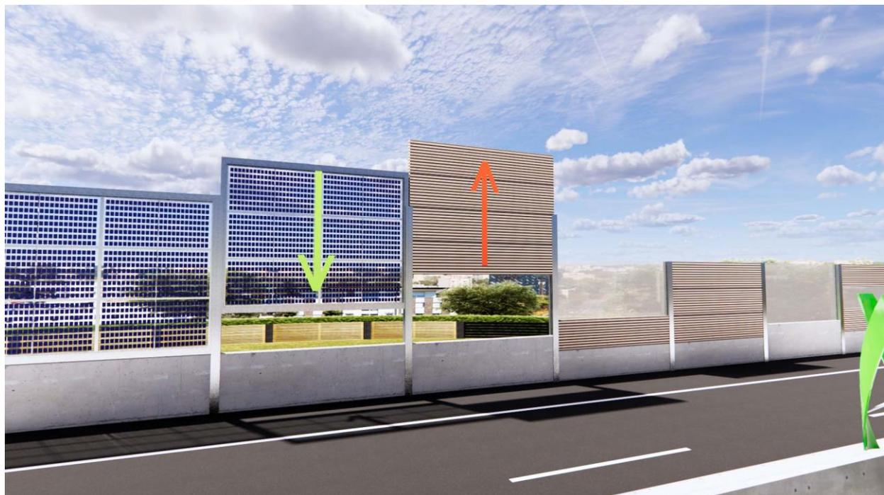
Nach der Entnahme der bestehenden Kassetten wird das neue Modulfeld eingesetzt
