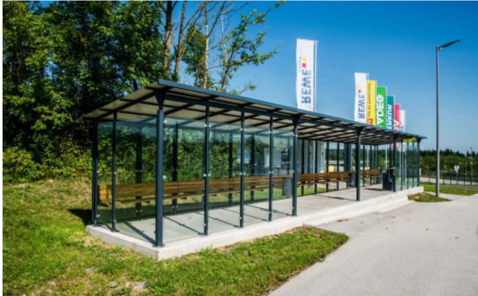
Kunde: REWE International AG Leistung: Wartehaus Logistikzentrum Ohlsdorf
