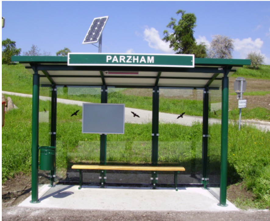
Kunde: Gemeinde Wallern a. d. Trattnach Leistung: Wartehaus mit Photovoltaikanlage inkl. LED-Beleuchtung
