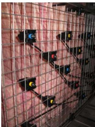
Der Serverraum wurde mit einer Luftkühlung auf Basis Verdunstungskälte ausgestattet.
