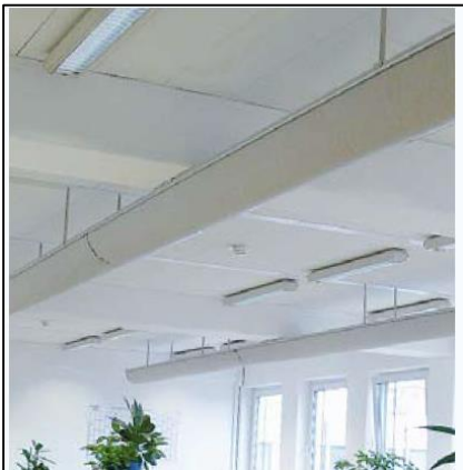
Beispielbild Textilkanal halbrund, Quelle: AirQuell GmbH
