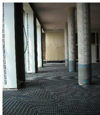
Oper Leipzig mit nachgerüstetem, thermisch aktivem Dünnschichtsystem
