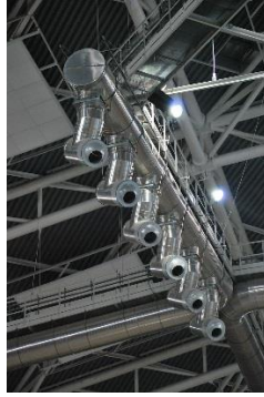
Sichtbare TGA (Lüftung und Ionisation)
