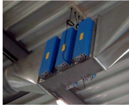
Sichtbare TGA (Lüftung und Ionisation)
