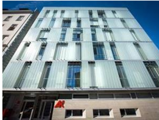
Bürogebäude Plösslgasse 2 1040 Wien
