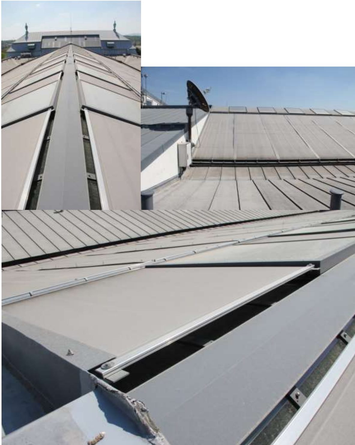
Ansicht des Daches der Mittelhalle/Haupthalle mit Sonnenschutzanlage
